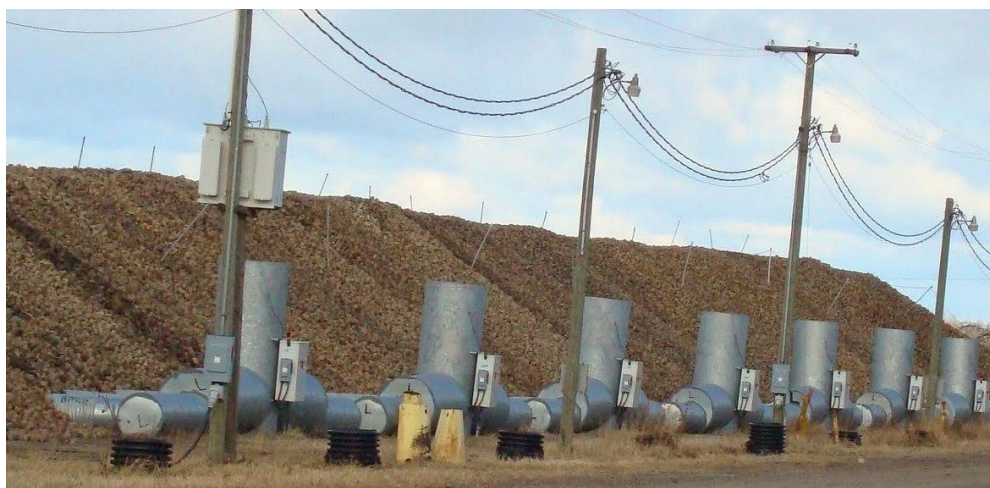
Рис. 13. Установки для активного вентилявання буряків цукрових
